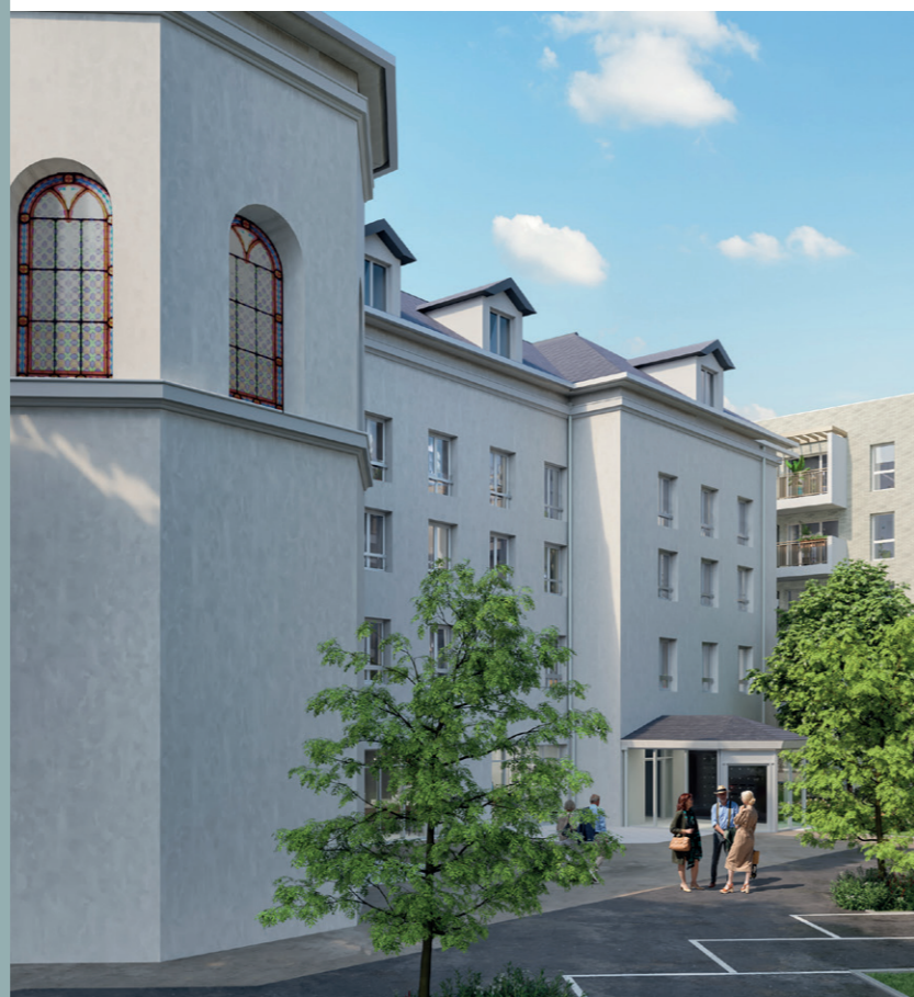
▼ Confluence À Montereau-Fault-Yonne (77) • Architecte : Posto29 MOA : Centre Hospitalier Sud Seine et Marne • Livraison au 2 ème trimestre 2024
