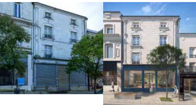
Résidence Cour Dupleix – Châtellerauld (86) – 40 lots – B²D Architectes – Réhabilitation de l'ancienne quincaillerie Quillet en logements et commerce – En chantier
