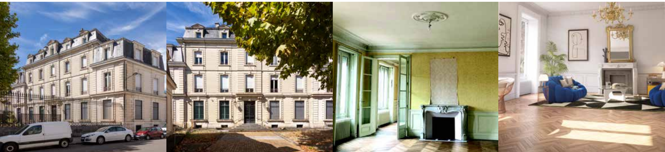
Résidence La Réserve – Périgueux (24) – 43 lots – Patrick Boussier Architecte D.P.L.G. – Réhabilitation de l'ancienne Banque de France en logements – En chantier Ci-dessus, photos du bâtiment et d'un exemple de séjour avec sa perspective 3D après travaux
