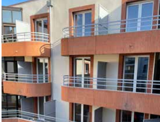
Chantier – cour intérieure
