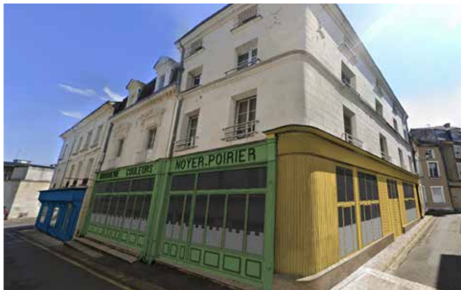
Résidence Cour Duplex – Châtellerauld (86) – 40 lots – B²D Architectes – Réhabilitation de l'ancienne quincaillerie Quillet en logements et commerce – En chantier
