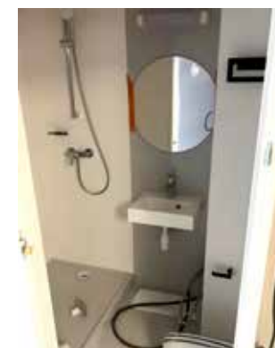
Résidence étudiante Ikasi – Bidart (64) – 115 lots – Patrick Boussier Architecte D.P.L.G. – Mise en place de modules de salles de bains préfabriqués (ci-dessous, en cours d'installation) – En chantier
